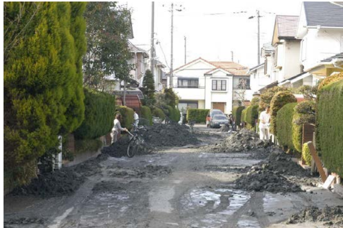
戸建て住宅地の液状化被害状況
