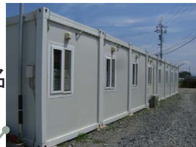
↑石巻市内の障がい者向け仮設住宅
