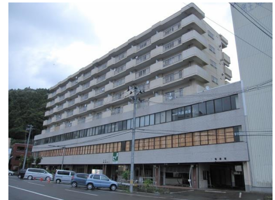
津波避難ビル（釜石）
