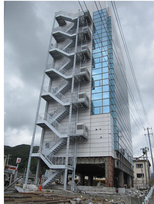
オフィスビル（釜石）
