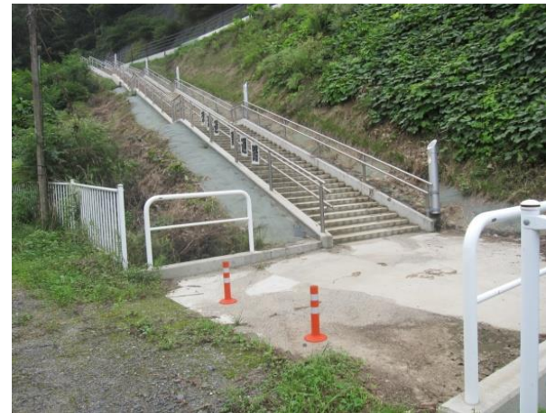
避難階段（小本小学校）
