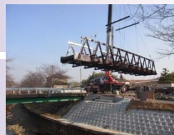
FRP骨組構造の 人力組立・一括架設
