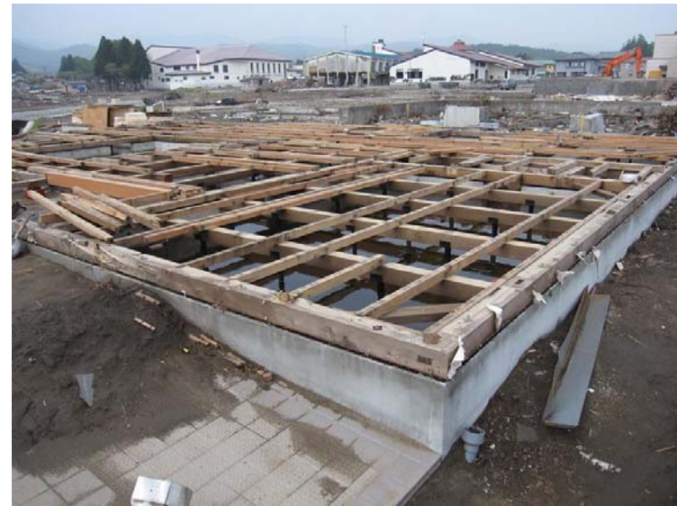
基礎構造残留（野田）
