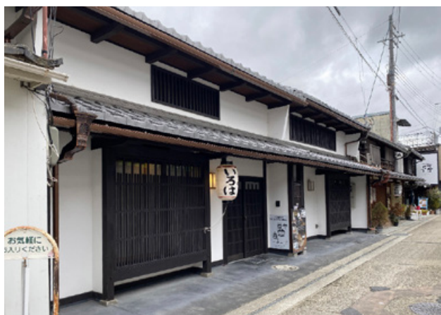
写真7 一棟貸しタイプ建物外観
