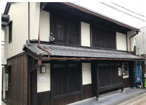
写真8 ワンルームタイプ建物外観
