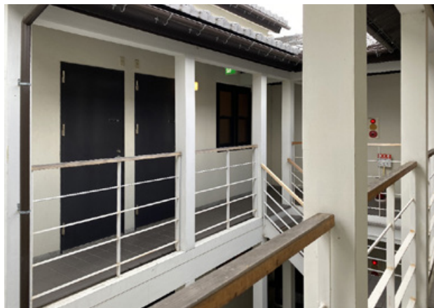
写真16 ワンルームタイプ棟共有外廊下
