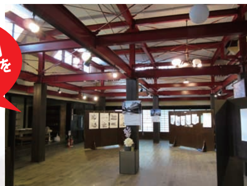
耐震補強された内部空間
