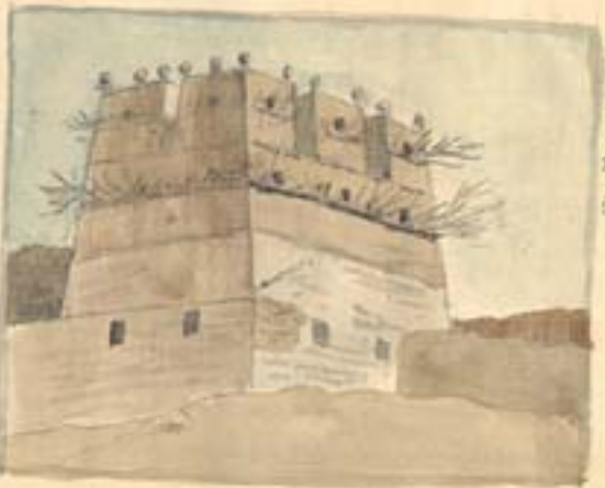
セーブルの塔屋
