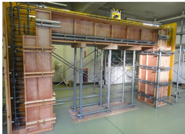
写真3 ラーメン1列の施工実習モデル
