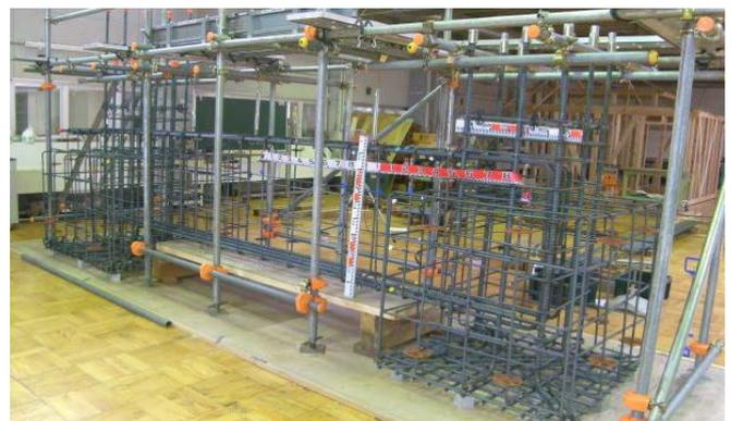
写真1 卒業研究の鉄筋施工状況（下部構造）
