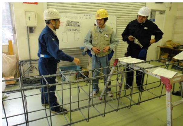
写真4 梁筋の仮組（地組）の状況
