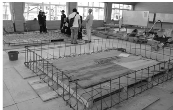
写真2. 施工実習では2基の実大住宅基礎を組立てた
