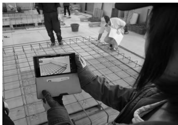
写真3. スマートフォンで次の施工手順を確認している状況
