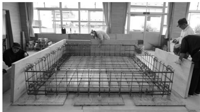
写真1. 住宅基礎の鉄筋・型枠の組立状況
