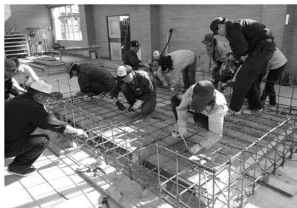
写真4. 住宅基礎の配筋作業の状況
