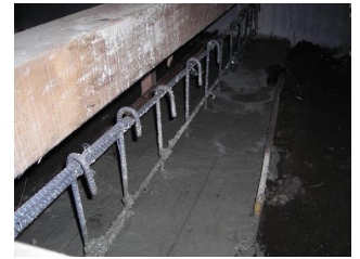
図 13. 新設 RC 布基礎
