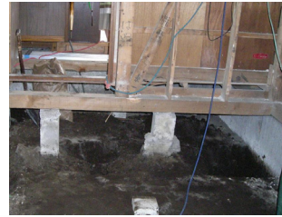
図 12. 基礎のない筋かい壁
