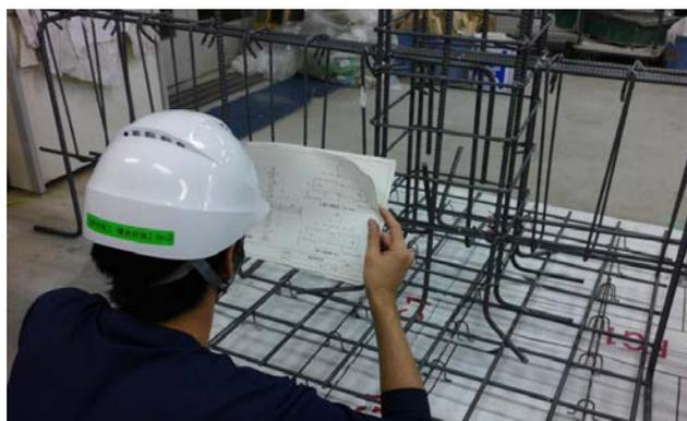
写真1 2次元図面のみによる鉄筋組立施工の様子<sup>文2)</sup>
