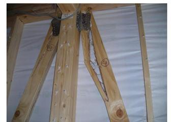
図 10. 筋かい端部の割れ
