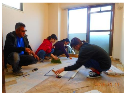
図 1 マンションリフォーム PBL（施工時）
