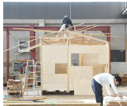
写真3 仮組作業の様子
