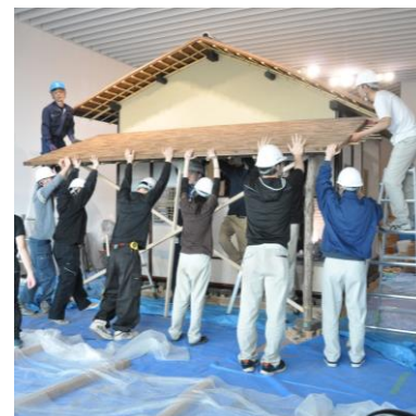
写真4 土間庇の設置の様子
