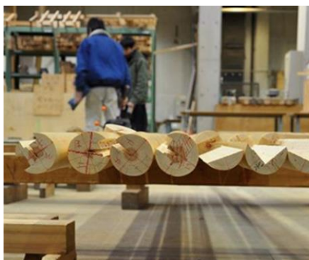
写真2 柱の墨付けと加工
