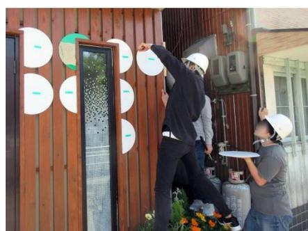
図 26 アクリル板の設置作業
