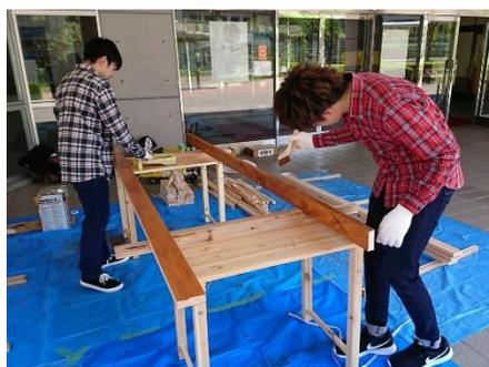
図 19 部材への着色防腐剤塗装
