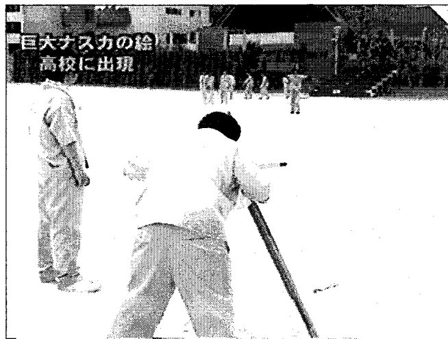
写真－８ ポールを視準し、向きを測定する。
