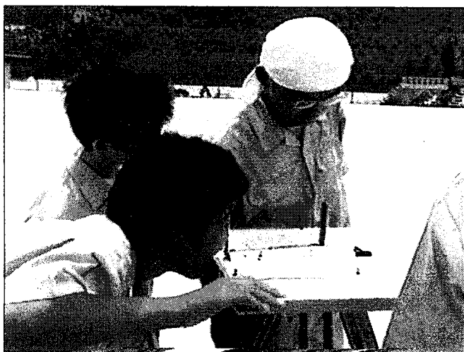
写真－５ ポールを視準し、手の動きで指示をおくる，
