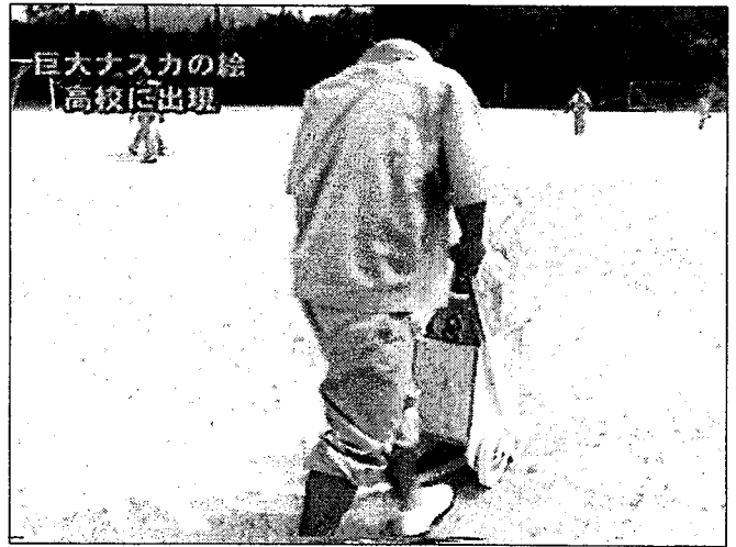
写真－１４ 測点を白石灰の線でつないでいく‡
