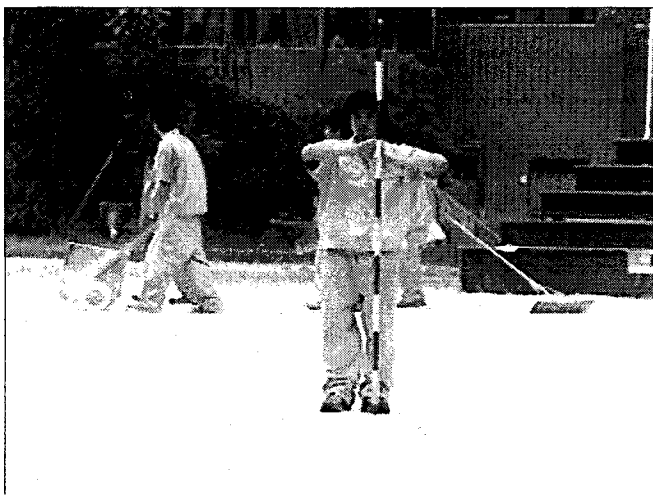
写真－７ ポールを持ち、向きを測定する。
