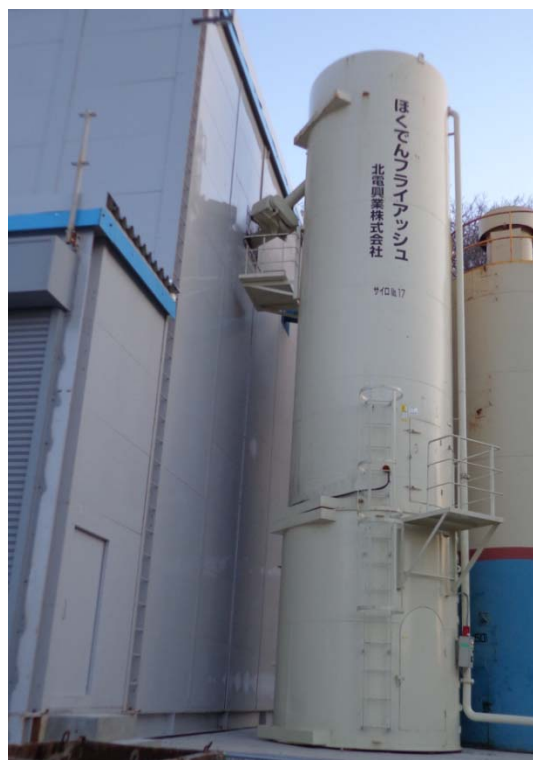
写真 38.2 フライアッシュサイロ 外観
