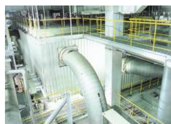
写真 6.1 高性能ボイラ
