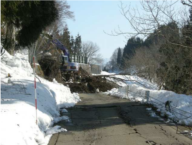
写真 31 道路の復旧作業
