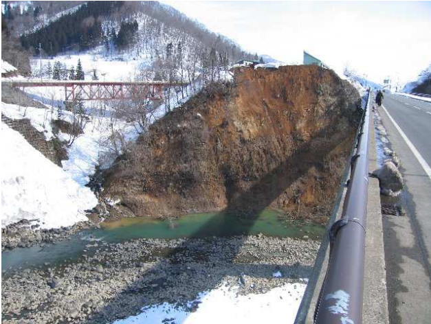
写真7 橋北東斜面の被害
