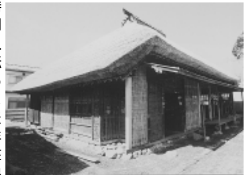
旧渡辺家住宅修復工事
