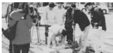
地域の方も参加した設置作業
