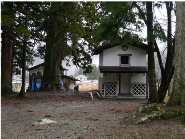
写真 25 土蔵：被害なし
