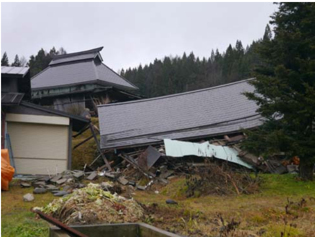
写真 37 倒壊した土蔵
