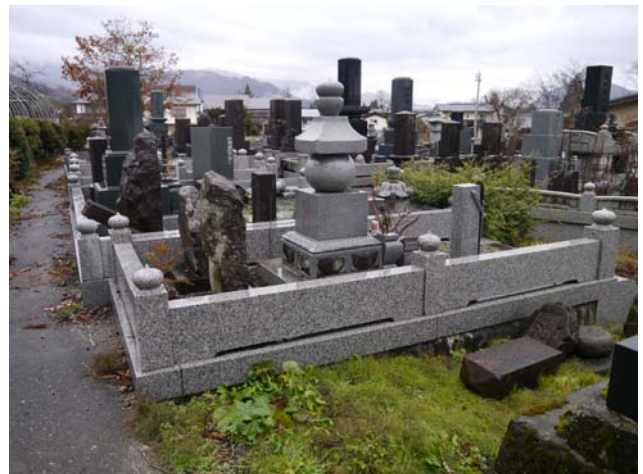
写真 34 墓石の転倒状況
