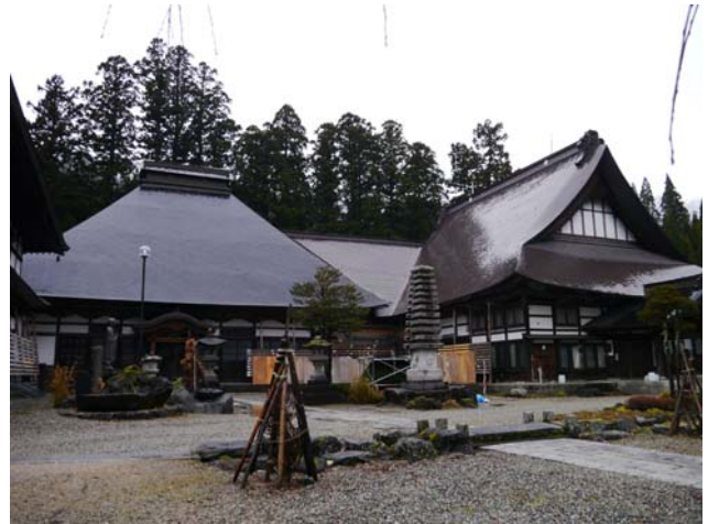
写真 32 本堂（左）と庫裏（右）：被害なし
