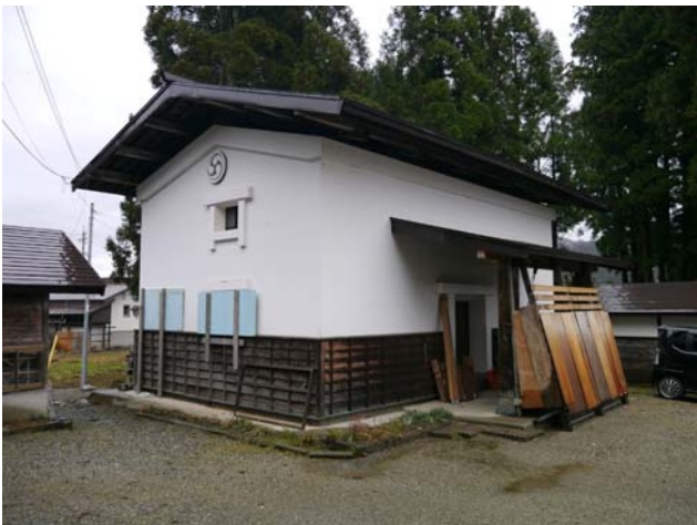
写真 33 土蔵：被害なし
