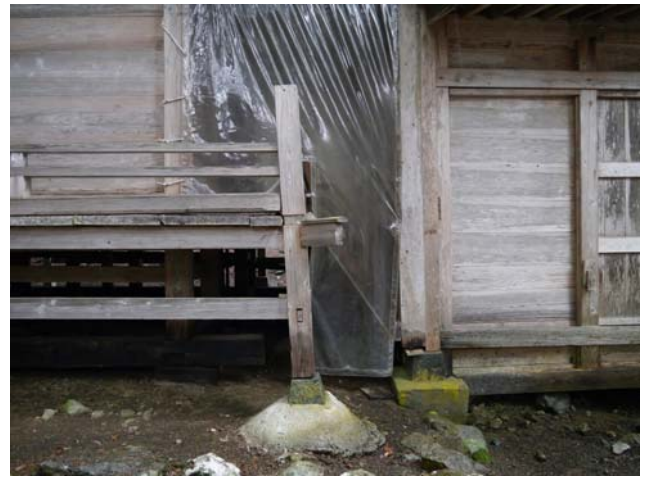
写真 18 幣殿と本殿との接続部分
