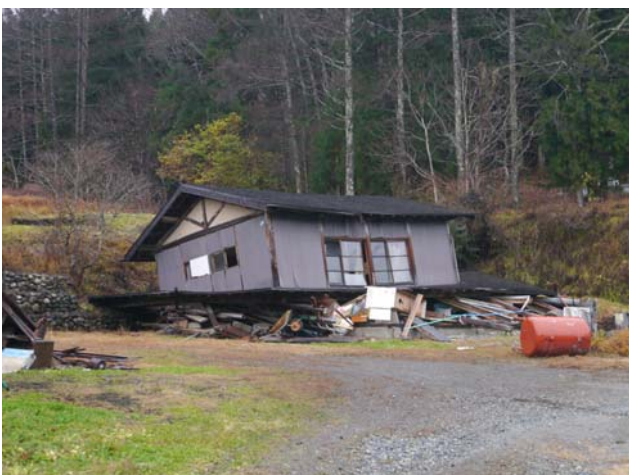
写真 39 倒壊した建物
