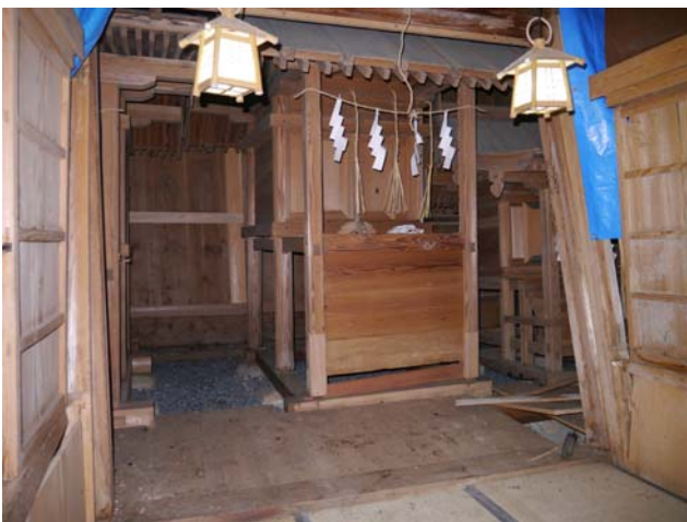
写真7 幣殿と本殿覆屋の接続部分
