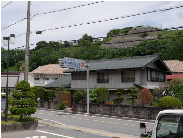
写真 1.1-1 木曾合同庁舎周辺 無被害
