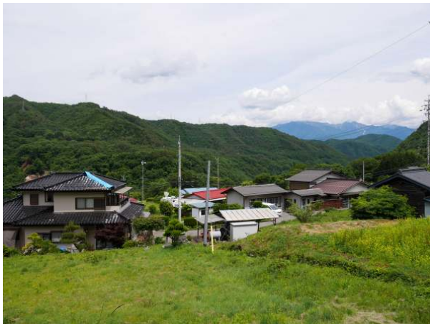
写真 1.4-3 瓦屋根の被害(左)、周辺は無被害
