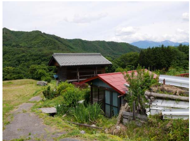
写真 1.4-4 瓦屋根の建物 無被害
