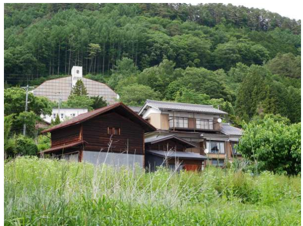
写真 2.1-4 役場周辺の建物 瓦屋根も無被害
