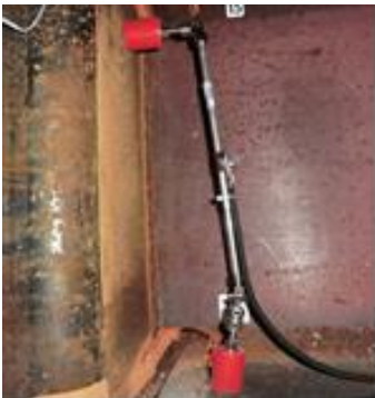
図7 損傷時センサ状況
