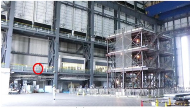
図1 実大3層鉄骨構造物
