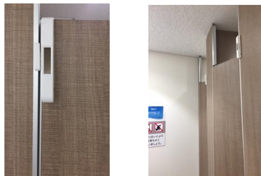
図-2 ドア開閉感知センサーの設置
