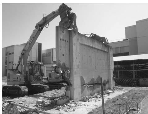
図－9 解体工事を模擬した実大 RC 部材のモニタリング実験の様子
