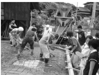
写真3 コンクリート基礎工事
