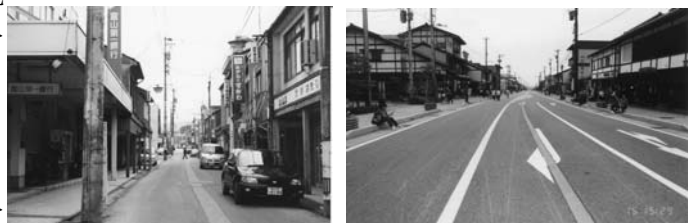
写真1 拡幅前の304号線（左）と拡幅後（右） 西上町
