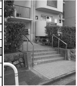
写真8 階段前手すり
