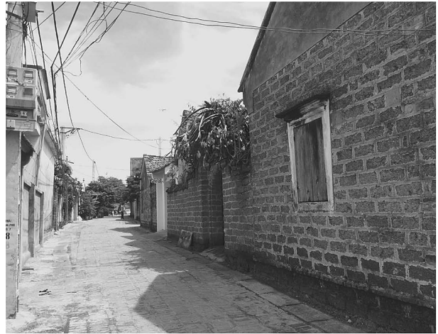
図3 ラテライト積み石塀によるドゥオンラム村の街路風景
