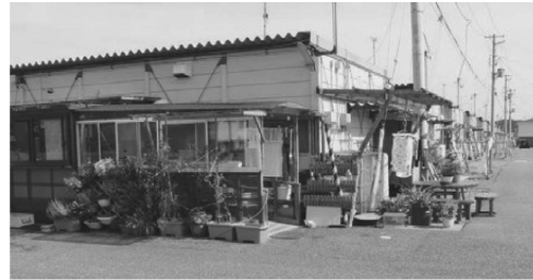
図1 住みこなしが進む仮設住宅
