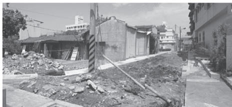
写真1 台湾高雄市の道路整備事業の工事現場（筆者撮影）
