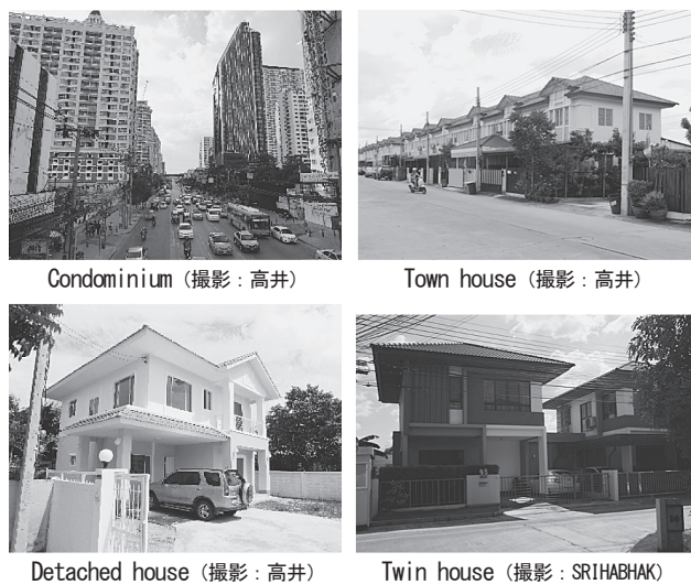
写真1 バンコクの代表的な住宅タイプの外観
