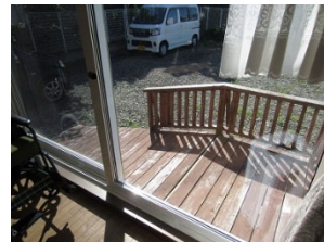
写真5. 2方向避難用スロープ
