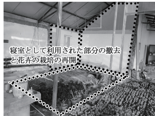
写真1 部分撤去されたビニールハウスの例
