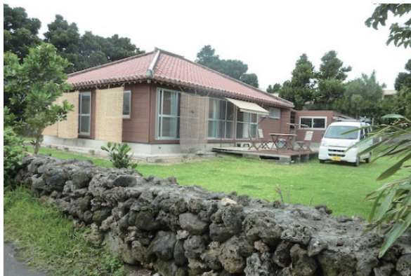
図4 Iターン者により新築された木造赤瓦住宅（番号1）
