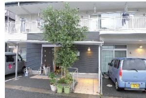
写真3. スロープ・庇(事例L)
