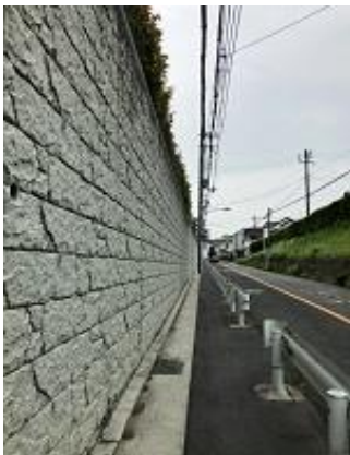
写真2 擁壁と歩道空間
