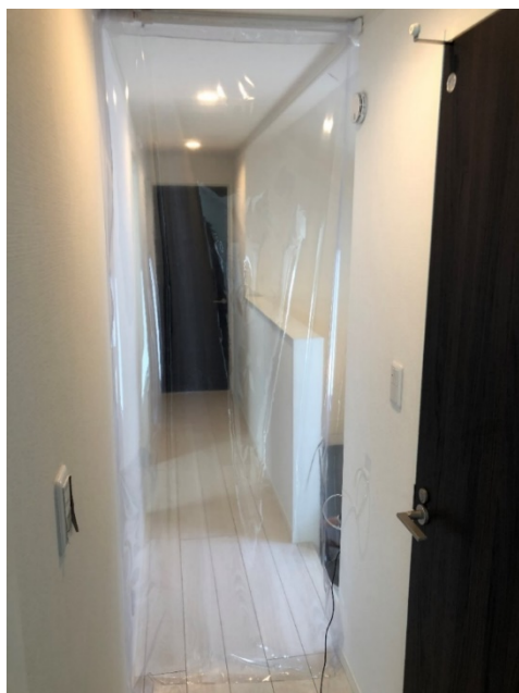
ビニールカーテンによる 廊下の間仕切り
