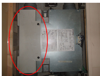
図 5 全熱交換器本体とフィルター
