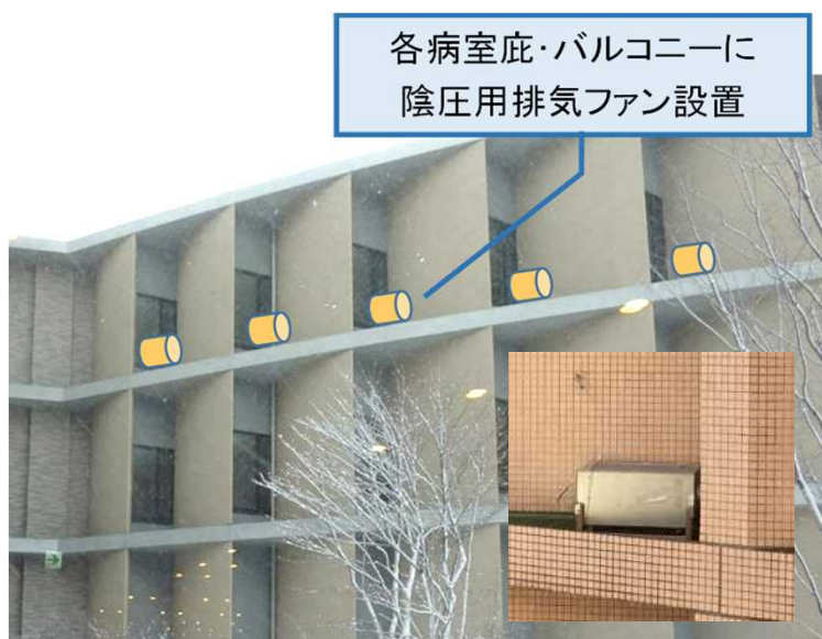
既存病室に専用の排気設備を設置
