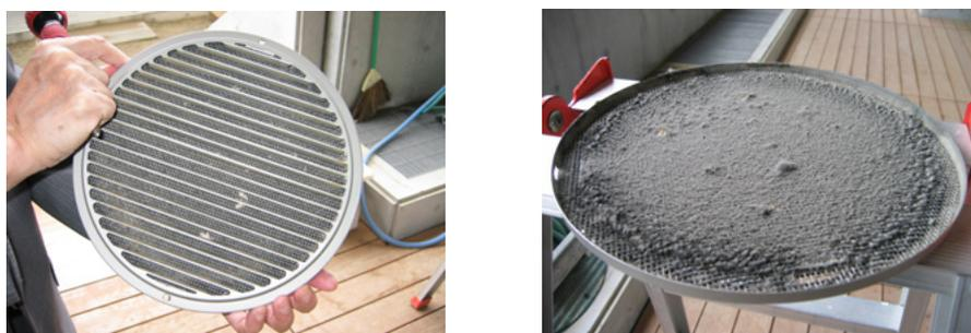
図 1-7 排気口防虫網に埃の堆積（左：表面、右：裏面）
