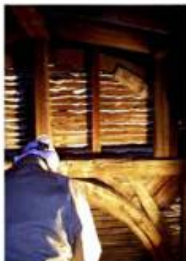
小屋裏ドーマー調査
