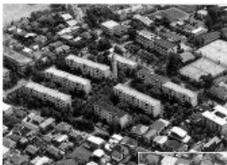
写真 1 建替え前の「千歳桜丘住宅」（北側から）
