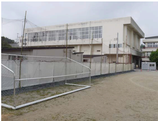
体育館と仮設住宅
