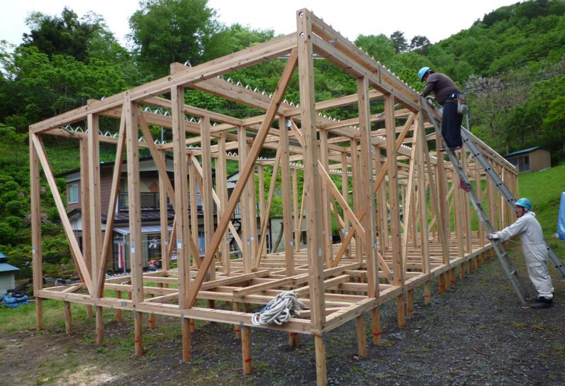
県内工務店による仮設住宅(宮古郊外の小さな集落)
