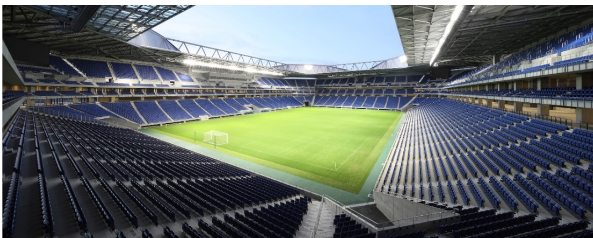
事例解説「市立吹田サッカースタジアム」鳥瞰・内観写真（設計施工：竹中工務店）
