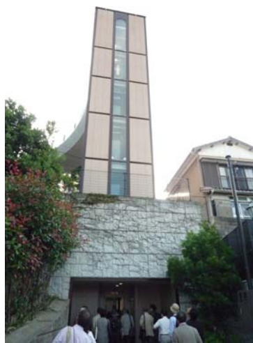
垂直エレベーター
