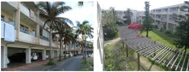
住棟の道路側の表情と囲まれた中庭空間
