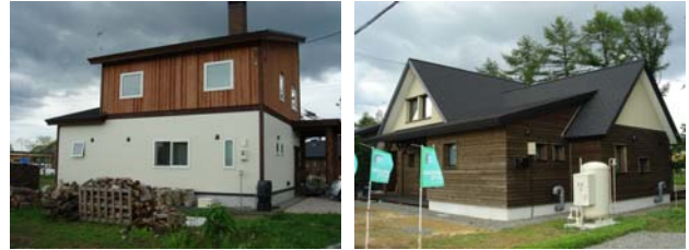
「建築ガイドライン」等に基づいて建築中の田園住宅
