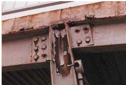
写真 CB2.13.1 接合部パネルの圧潰
