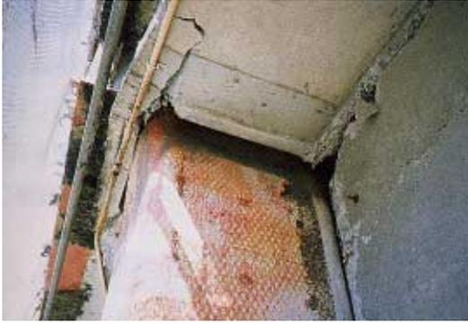
写真 CL1.1.1 柱頭部の局部座屈
