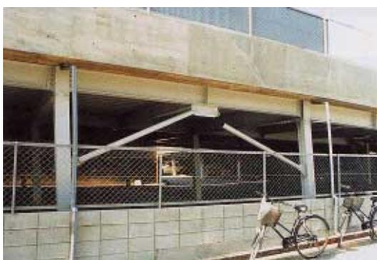
写真 BR1.7.1 鋼管ブレース端部の破断
