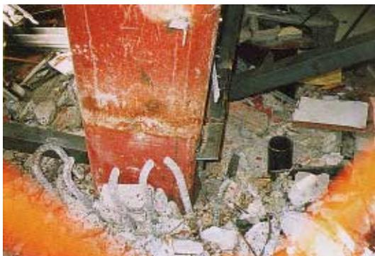
写真 CB1.23.2 根巻コンクリート除去後の柱脚部
