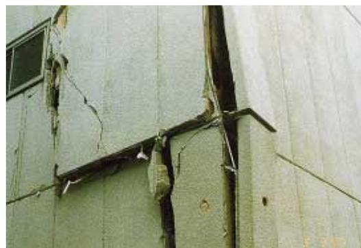
写真 FS3.1.4 出隅部 ALC 板の亀裂
