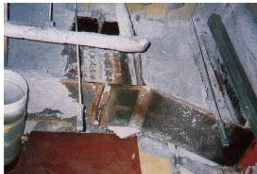
写真 CB1.12.5 現場梁継手の溶接部の破断
