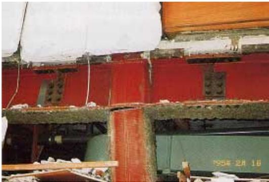
写真 CB1.27.1 柱端・梁端すみ肉溶接部の破断
