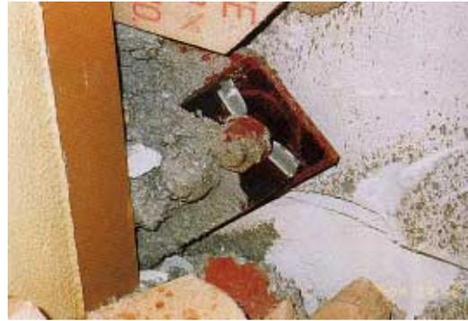
写真 BS2.6.2 筋違端部の破断
