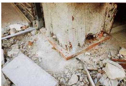
写真 BS1.2.1 アンカーボルトの破断と建物の移動
