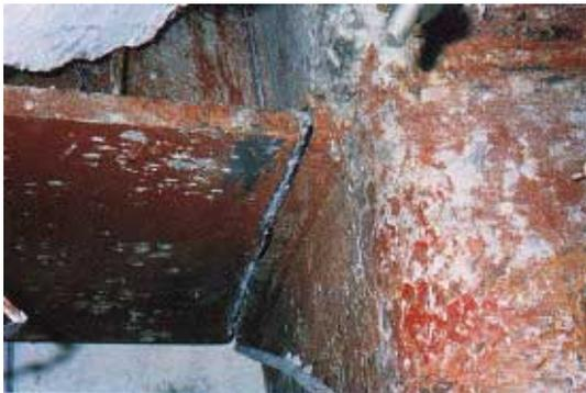
写真 CB1.14.1 梁フランジ溶接部の破断
