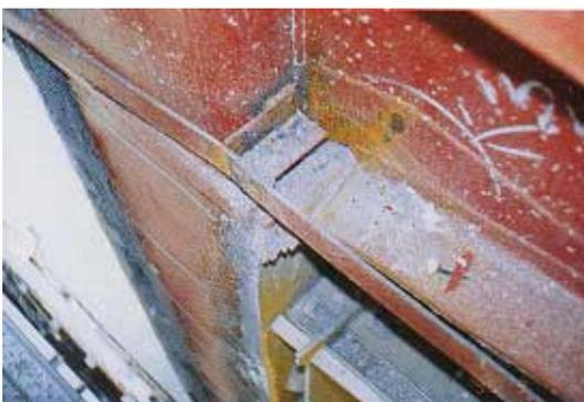
写真 CB1.5.1 下フランジの破断
