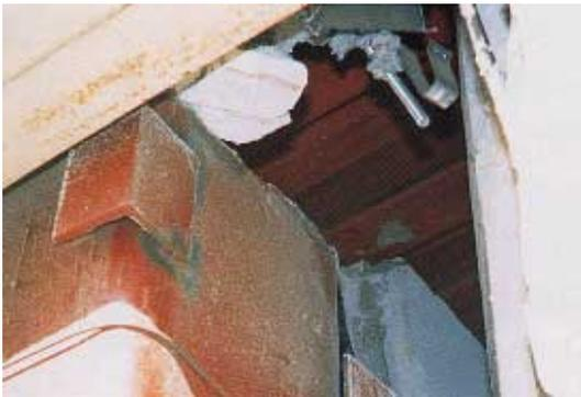
写真 CB1.37.1 柱梁仕口における柱溶接部の破断
