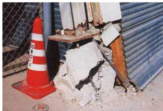
写真 BS2.3.2 柱脚コンクリート部の破壊
