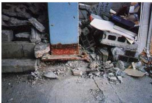
写真 BM1.3.3 柱脚の損傷
