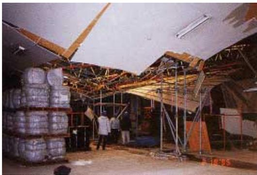
写真 SP1.3.2 トラス梁の落下による天井の破損
