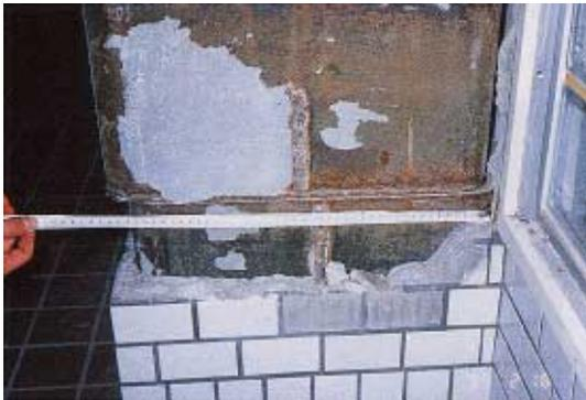
写真 CL2.4.2 上部構造物の移動
