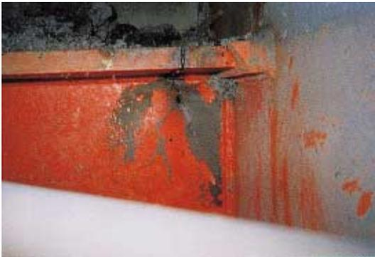
写真 BM1.4.2 梁上フランジの破断とウェブの亀裂
