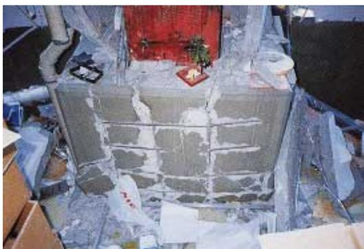
写真 BS 3.4.2 根巻柱脚の損傷
