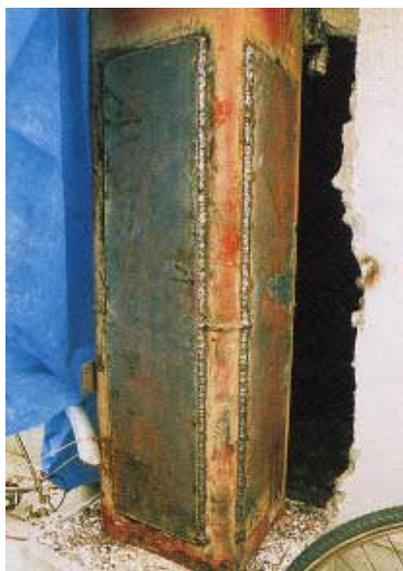
写真 CL2.2.2 補修を施した柱
