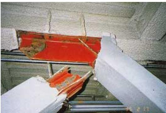
写真 BR 1.10.1 筋違端部の破壊
