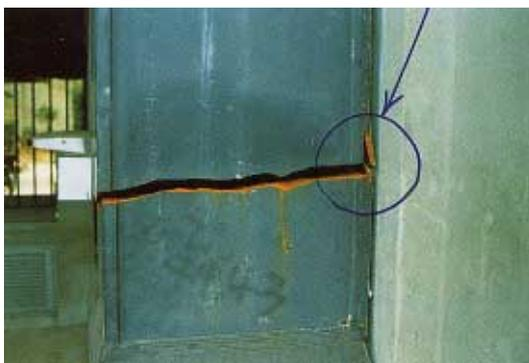
写真 CL3.1.2 弦材の母材破断と当て板の延性破断
