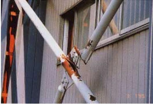
写真 BR1.15.1 円形鋼管 X 形筋違の破断
