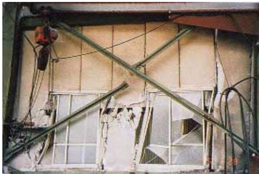
写真 BR1.8.1 山形鋼 X 型筋違の破断
