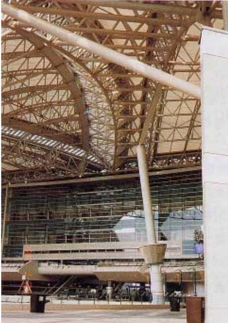
写真 SP1.2.1 支持柱の傾斜
