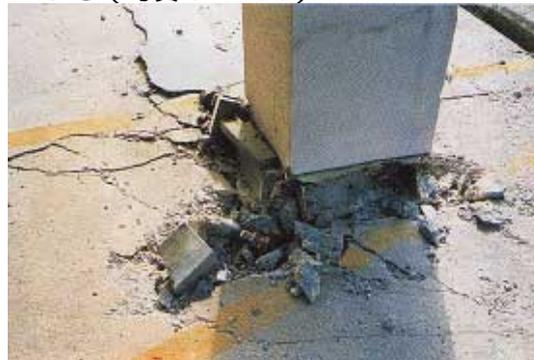
写真 CB1.19.3 柱脚アンカーボルトの破断
