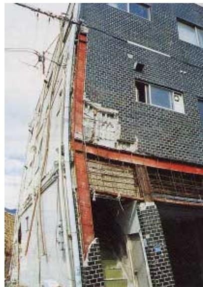
写真 CB2.9.3 1 ~ 2階隅柱の曲げねじれ変形
