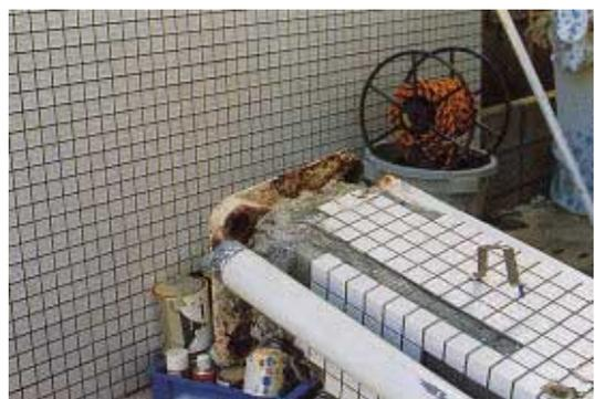
写真CB1.34.3 アンカーボルトが無く転倒した柱
