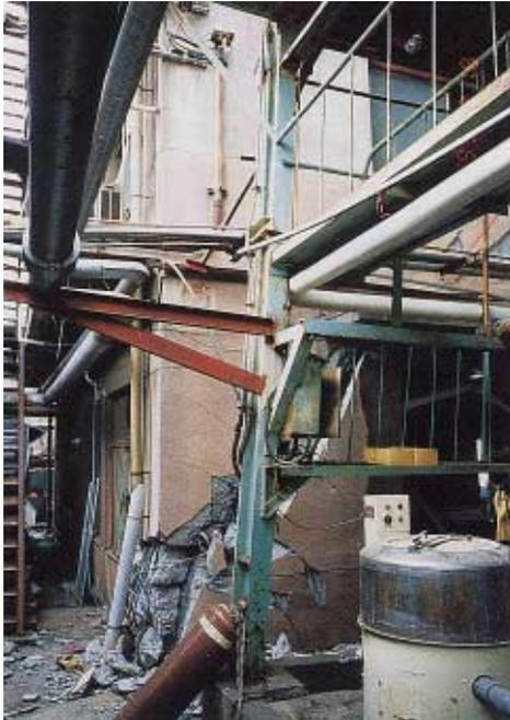
写真 CL4.6.1 1階 H形鋼柱の弱軸方向曲げ
