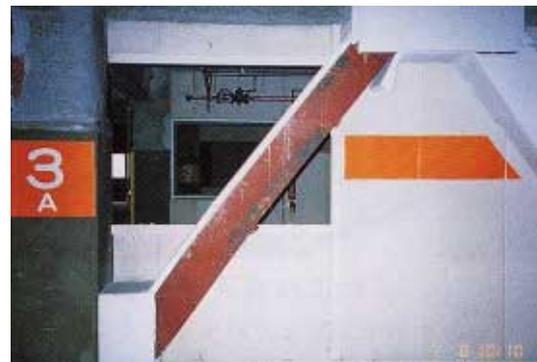
写真 CL1.4.5 H形鋼筋違の座屈
