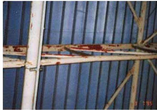
写真 BR1.15.3 屋根トラス弦材の座屈
