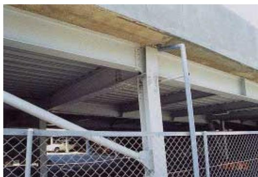
写真 BR1.7.3 柱頭の弱軸方向曲げ変形
