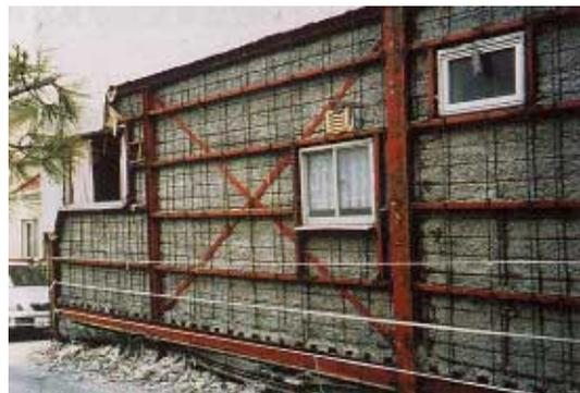
写真 CL4.5.2 弱軸曲げ方向のX形筋違
