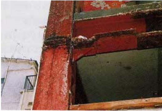
写真 CB3.1.1 日の字カバープレートの面外曲げ
