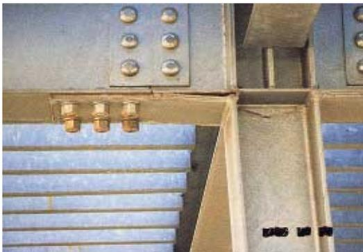
写真 CB2.6.1 1階柱頭部の亀裂
