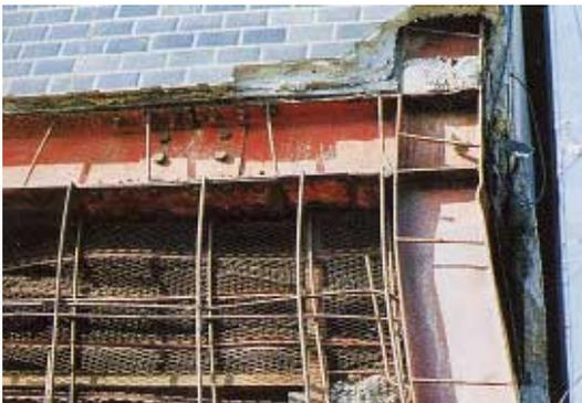
写真 CB2.9.2 柱頭部フランジの局部座屈
