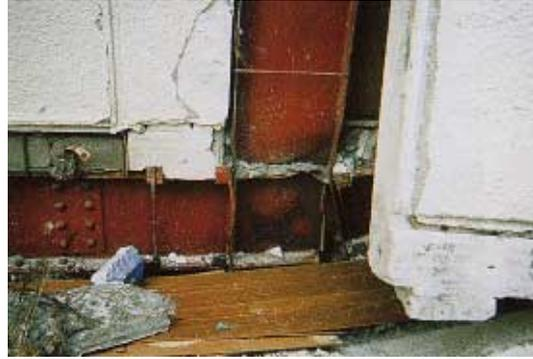
写真 CL4.4.2 仕口パネルの局部座屈
