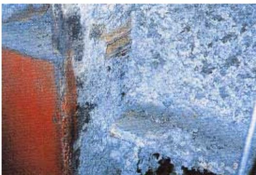
写真 CB3.2.2 梁下フランジすみ肉溶接部の破断
