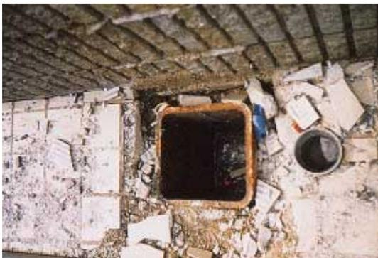
写真 CL2.5.1 柱現場溶接継手の破断
