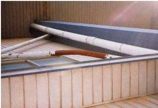
写真BR1.15.2 円形鋼管X形筋違の座屈
