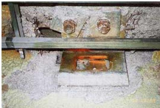
写真 FS2.1.1 プレキャストコンクリート板取付け金具のボルト破断
