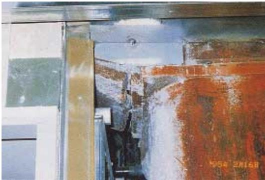
写真 CB1.2.2 下フランジハンチ部の破断
