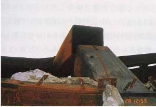
写真 CL2.6.1 柱継手溶接部の破断
