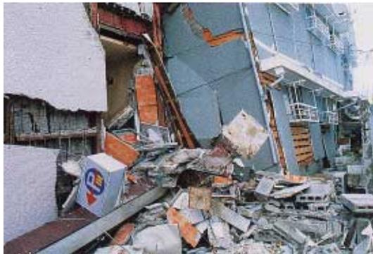
写真 CB2.3.1 倒壊した1階柱
