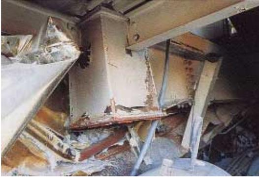
写真 CB1.22.1 破断した1階柱頭仕口
