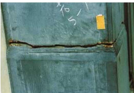
写真 CL.3.1.7 弦材継手溶接部の破断
