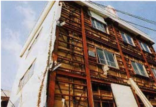
写真 FS1.1.1 外壁モルタルの落下
