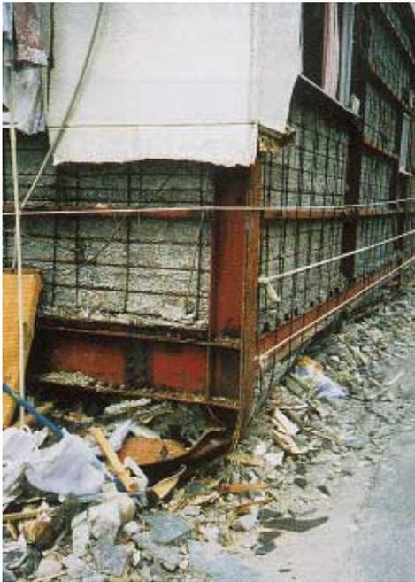
写真 CL4.5.1 強軸曲げ方向に倒壊した柱
