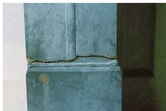
写真 CL.3.1.8 弦材継手溶接部の破断
