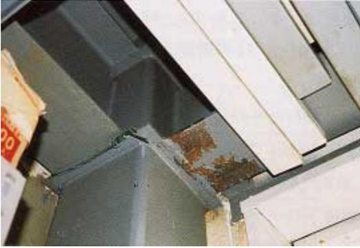
写真 BM1.1.1 2階梁下フランジの塗料の剥離
