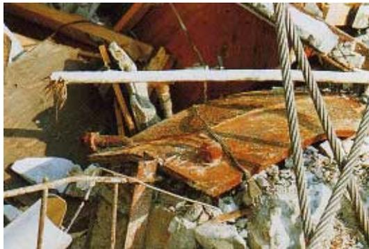
写真 BS2.1.1 面外に曲げ変形したベースプレート
