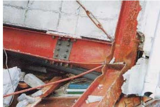
写真 CB2.5.2 1階柱頭の変形状況
