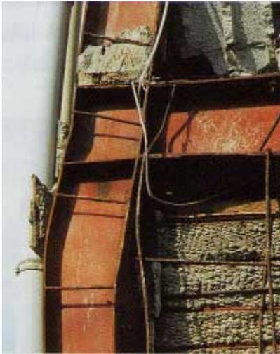
写真 CB2.9.1 仕口パネルのせん断変形
