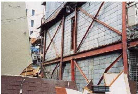
写真 BR1.5.1 筋違の座屈と端部破断
