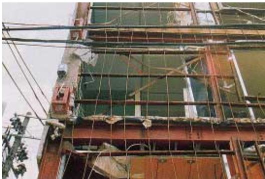
写真 BR1.4.1 平鋼筋違の部材座屈と破断
