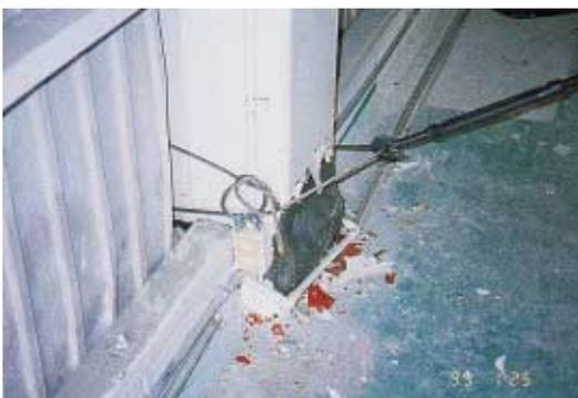
写真 CL1.2.1 柱脚部の局部座屈
