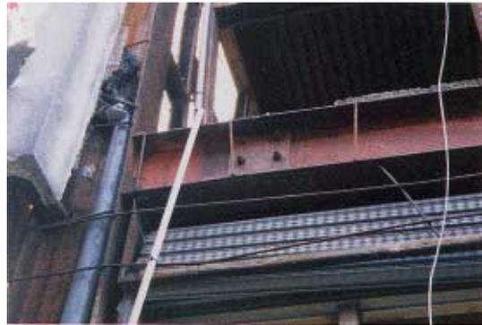
写真 CB2.12.2 梁継手ボルトの破断
