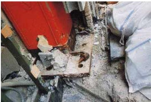
写真 BS1.4.1 アンカーボルトの破断
