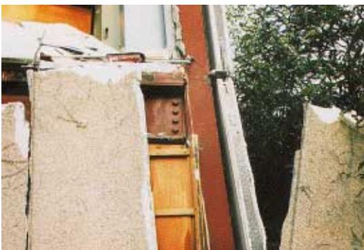
写真 CB3.5.1 シャーププレートの破断
