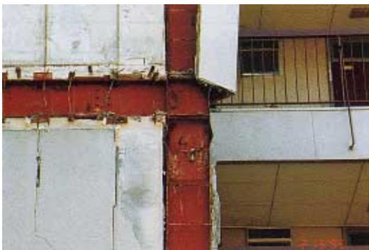
写真 CL4.2.1 H形鋼柱フランジの局部座屈
