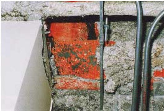
写真 CB1.6.1 下フランジの局部座屈と破断
