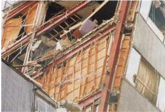
写真 BR1.3.1 平鋼筋違の部材座屈と破断
