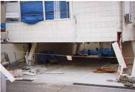
写真 CB1.32.1 1階柱の変形状況
