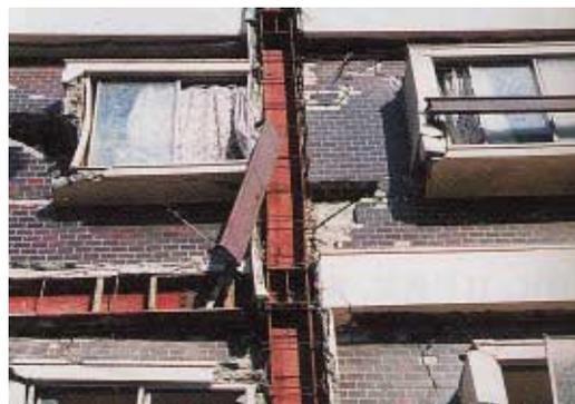
写真 CB2.7.3 3階柱の曲げ座屈
