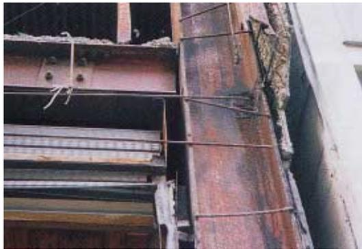
写真 CB2.12.1 梁端仕口の破断
