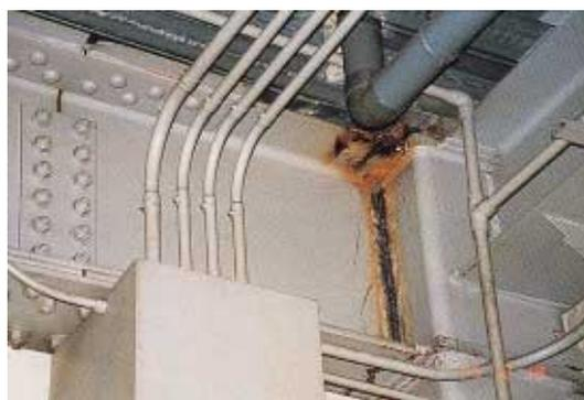
写真 CB1.17.3 2階床梁端仕口の溶接補修
