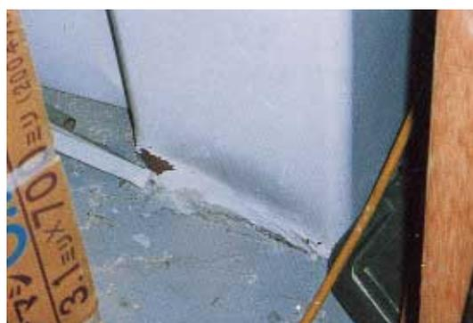
写真 CB1.28.2 柱脚部の局部座屈
