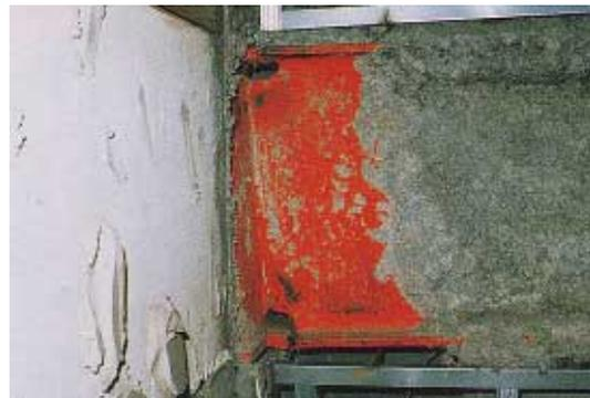
写真 CB1.6.5 階段室の梁端部の破断
