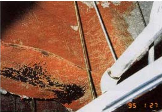
写真 BM.1.2.1 梁下フランジの局部座屈
