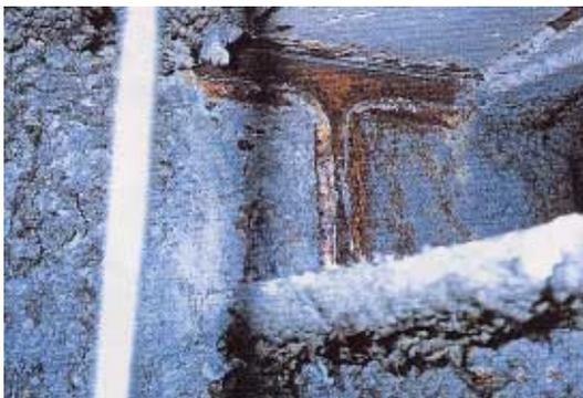
写真 CB3.2.1 梁上フランジすみ肉溶接部の破断
