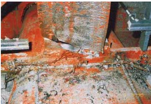
写真 CB1.6.4 下フランジの延性破断
