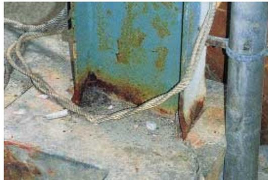
写真 CL4.6.2 柱脚のフランジ局部座屈
