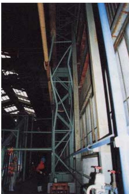
写真 ER1.4.1 トラス筋違の個材座屈
