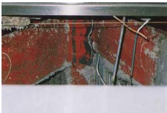
写真 BR1.9.1 筋違上端部の破断
