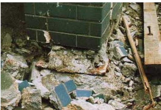
写真 BS1.7.1 アンカーボルトの破断
