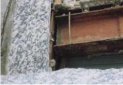
写真 CB2.1.1 2階床梁端溶接部の破断
