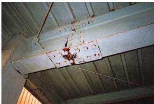
写真 BM1.3.1 フランジ添板の塑性化および亀裂
