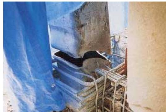
写真 CL1.4.3 コンクリート除去後の柱脚
