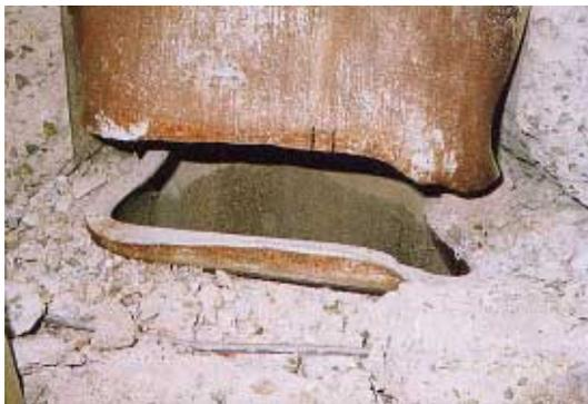
写真 CL1.4.2 柱脚部の局部座屈と破断
