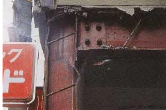
写真CB2.14.2 柱フランジの局部座屈
