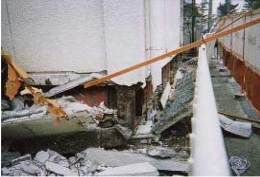
写真 CL4.4.1 弱軸曲げ方向に倒壊した柱
