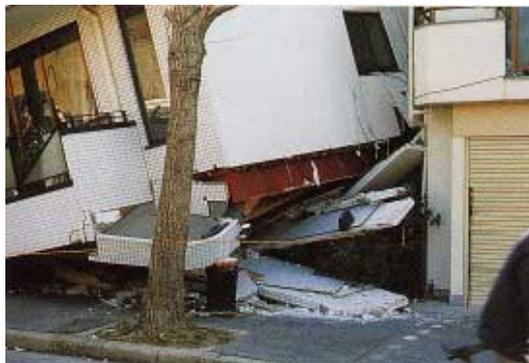
写真CB1.34.1 倒壊した1階部分
