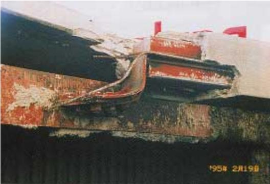
写真 BR1.12.2 端部ガセットプレートの面外曲げ
