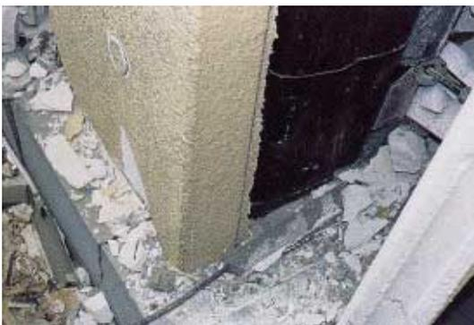
写真 CB1.37.2 柱脚の被りコンクリートのひび割れ
