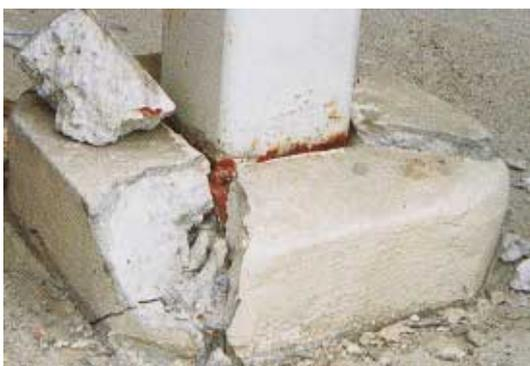
写真 CB1.20.2 柱脚の損傷
