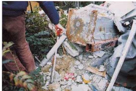
写真CB1.33.2 アンカーボルトの引抜き
