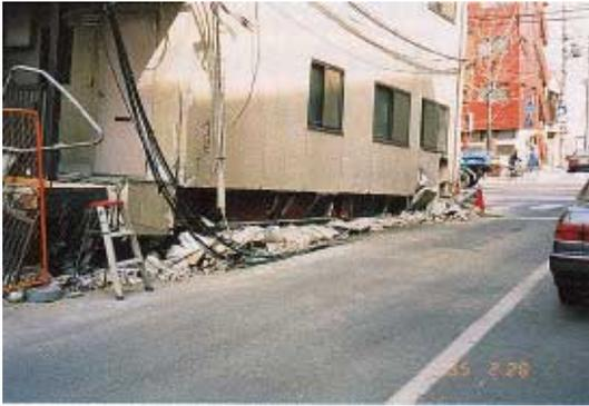
写真 CB1.29.1 1階の倒壊
