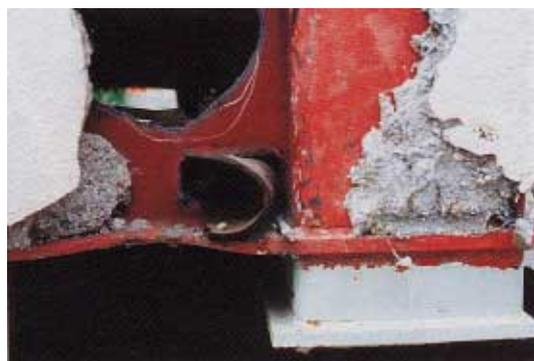
写真 CB1.35.2 2階床梁端仕口の梁フランジ局部座屈
