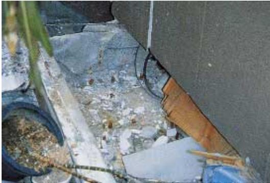
写真 BS1.3.1 アンカーボルトの破断と建物の移動
