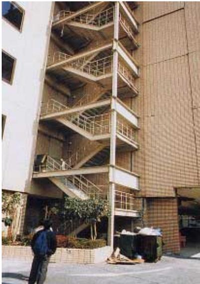
写真 ER1.2.1 外部鉄骨階段
