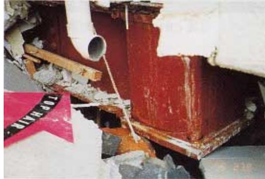
写真 CB1.31.2 2階仕口パネルの亀裂
