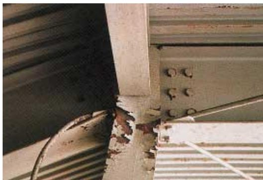
写真 CB2.13.2 H形鋼柱の塑性化
