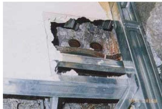
写真 CB1.2.6 ウェブ高力ボルトの破断
