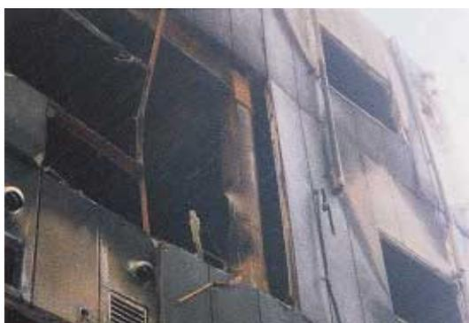
写真 CL1.6.1 鋼管柱の開裂
