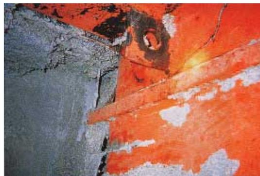
写真 CB1.13.4 鋼管壁の亀裂
