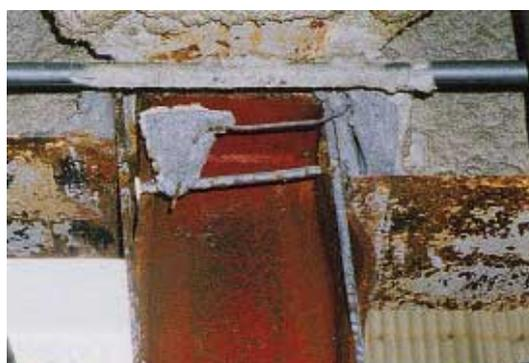
写真 BR 1.10.3 柱フランジの面外変形
