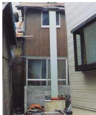
写真 CB1.35.3 柱頭溶接部が破断した1階柱
