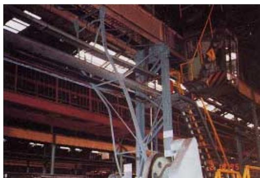
写真 ER1.4.2 トラス筋違の個材座屈
