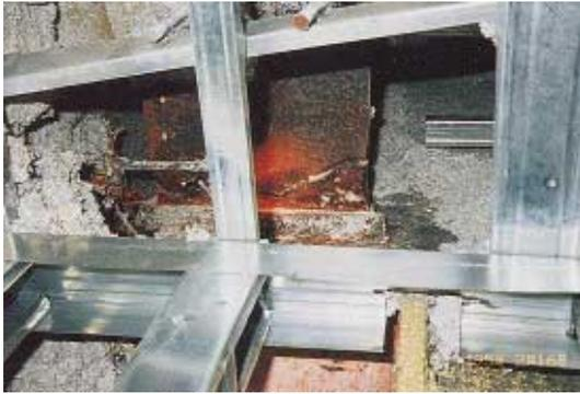
写真 CB1.2.1 下フランジの破断
