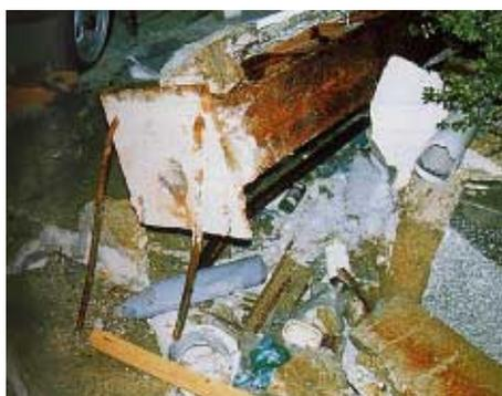
写真 BS1.1.2 アンカーボルトの引抜き
