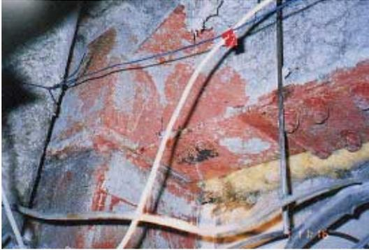
写真 CB1.10.1 梁下フランジの破断
