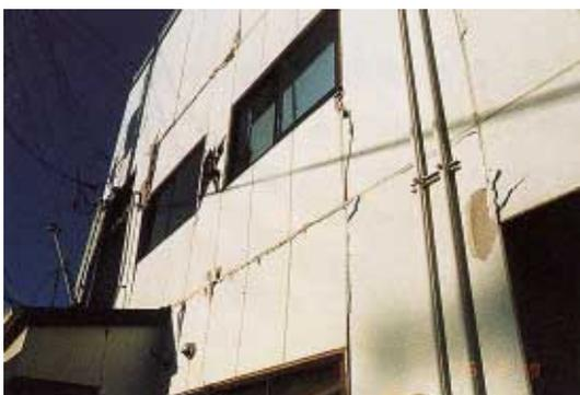
写真 FS3.1.2 ALC 板水平方向の亀裂とせん断破壊
