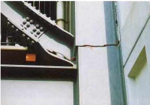
写真 CL.3.1.4 弦材破断から斜材への破壊伝播
