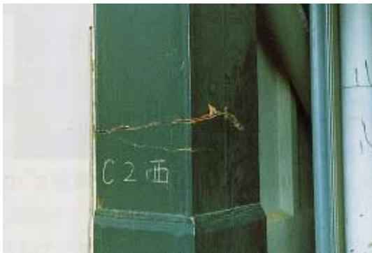
写真 CL3.1.1 弦材継手上部の母材破断
