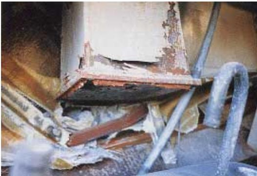
写真 CB1.22.2 仕口の破断面
