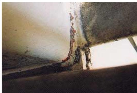
写真 CB1.38.3 コーナー部分の溶接部の亀裂
