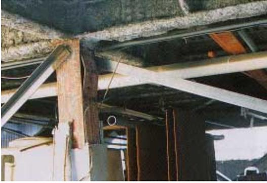
写真 CB3.3.1 日の字カバープレートの面外曲げ変形
