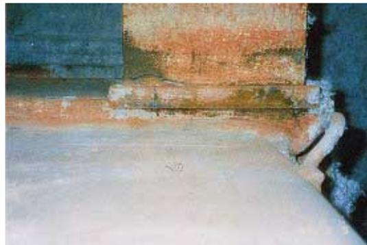
写真 CB1.8.1 梁下フランジの破断部とスカラップ
