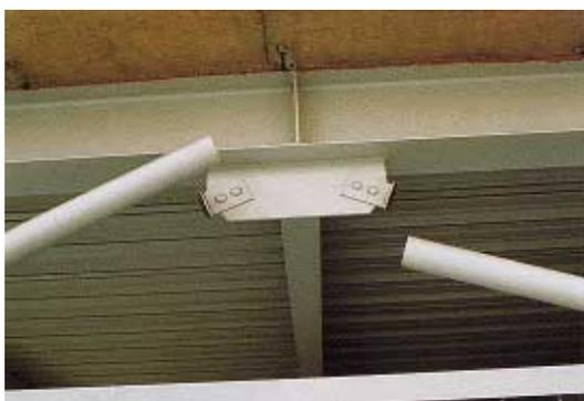
写真 BR1.7.2 鋼管ブレース端部の破断
