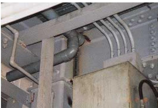
写真 CB1.17.2 2階床梁端仕口の溶接補修
