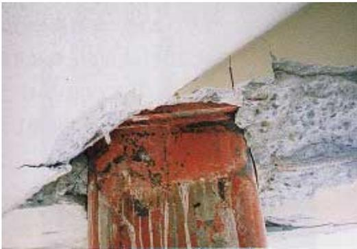
写真 CL1.1.2 柱頭部の局部座屈
