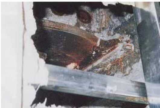
写真 CB1.2.5 フランジの局部座屈と破断
