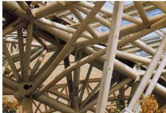
写真 SP1.2.2 部材座屈と接合部での破断
