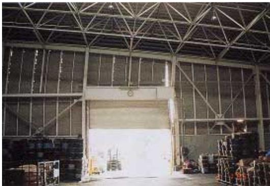
写真 SP1.1.2 H形鋼柱の全体座屈
