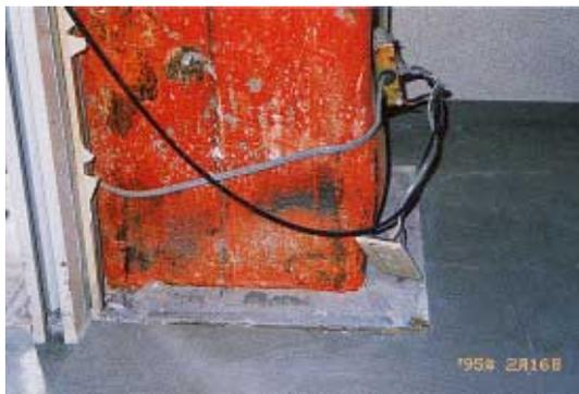
写真 CB1.3.5 柱脚部の局部座屈
