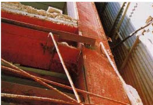
写真 CB3.1.2 梁受け金物溶接部の破断
