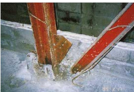
写真 BR 1.10.2 柱脚部の損傷
