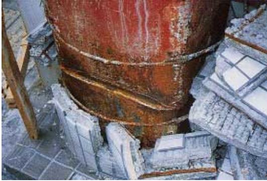
写真 CL2.4.1 柱継手溶接部の破断
