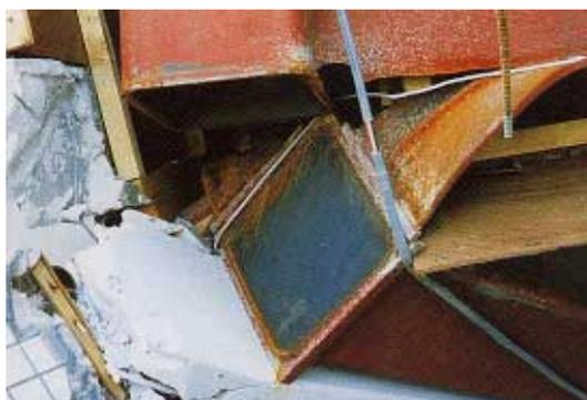
写真CB1.34.2 2階床梁仕口の溶接部の破断
