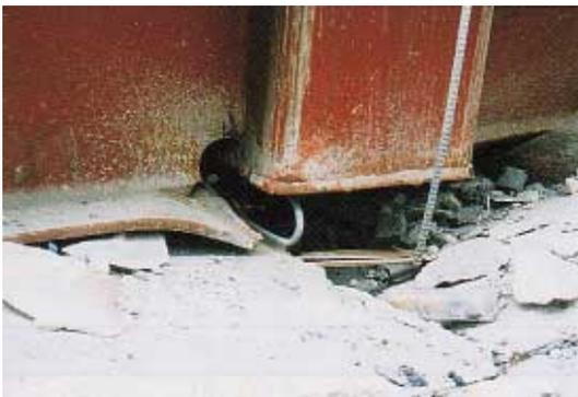
写真 CB1.29.2 柱頭仕口パネル側の破断
