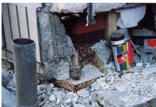
写真 BS1.13.1 柱脚アンカーボルトの伸び
