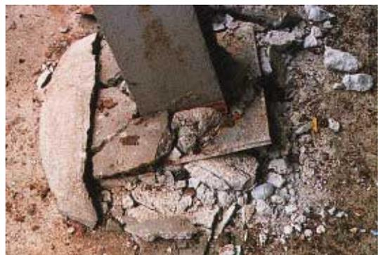
写真 CB2.13.3 柱脚アンカーボルトの破断
