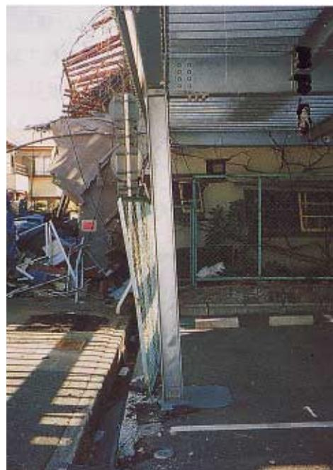
写真 CB2.6.3 1階の残留層変形
