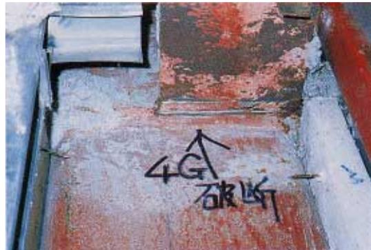
写真 CB1.10.3 梁下フランジの破断
