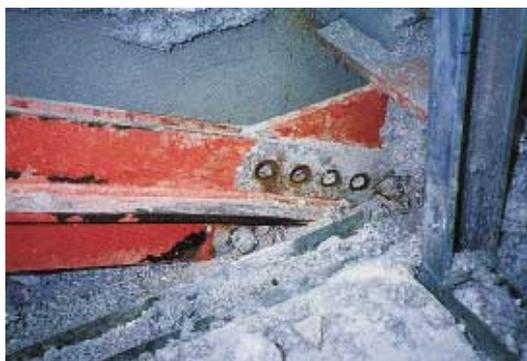
写真 BR1.17.2 ボルトの破断
