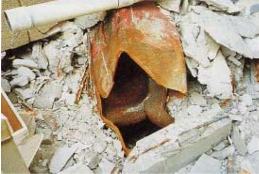
写真 CB1.31.1 柱脚における柱の曲げ破断
