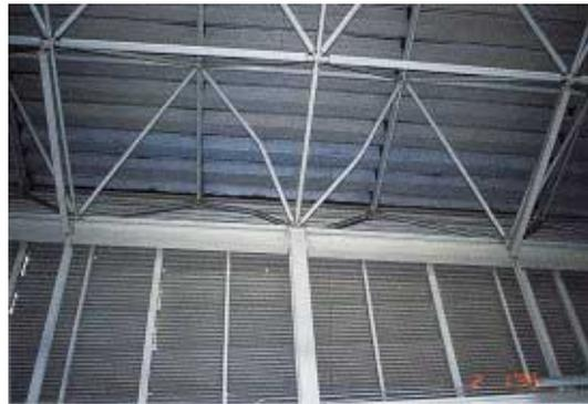
写真 SP1.1.3 立体トラス斜材の座屈
