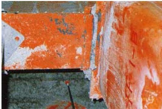
写真 CB1.3.1 ダイアフラム側熱影響部の破断
