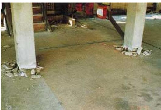
写真 BS1.5.1 土間コンクリートの破損
