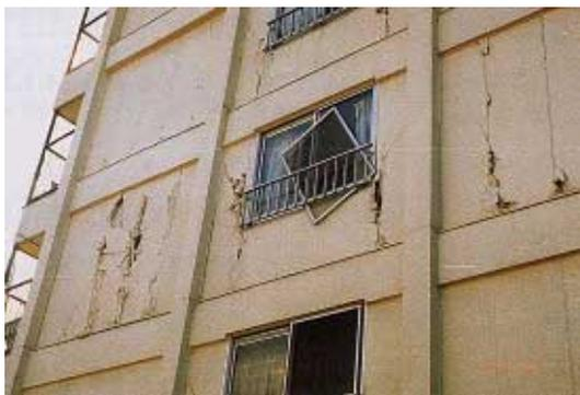
写真 FS3.1.1 ALC 板鉛直方向の亀裂
