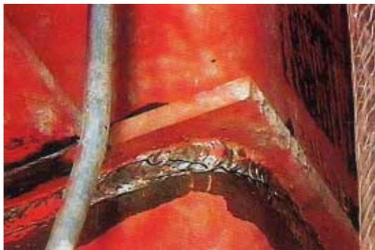
写真 CB1.12.4 鋼管コーナー溶接部の亀裂
