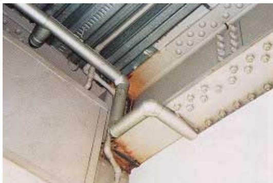
写真 CB1.17.1 2階床梁端仕口の溶接補修
