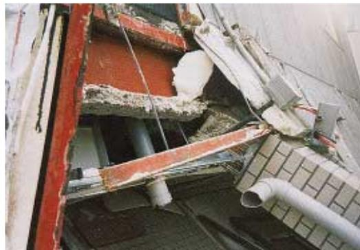
写真 CL2.5.2 柱頭仕口の破断
