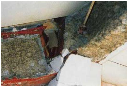
写真 CB1.19.2 梁端仕口の破断
