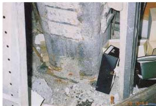
写真 BS 3.4.3 柱脚部の移動
