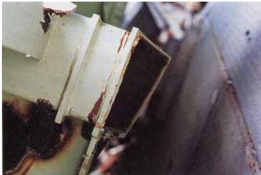
写真 CB1.35.1 1階柱頭仕口の溶接破断部
