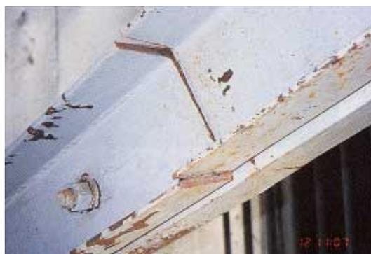
写真 BR1.11.3 筋違の破断
