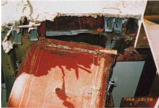
写真 CB1.23.1 柱・梁仕口溶接部の破断
