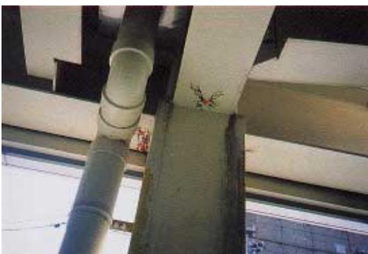
写真 CB1.38.1 梁端部の塗料の剥離
