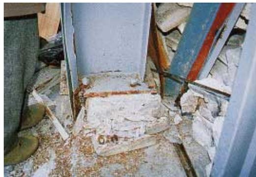
写真 BS2.2.2 アンカーボルトの破断
