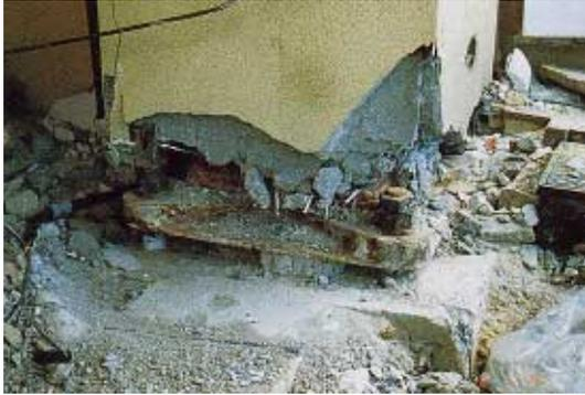
写真 BS2.6.1 柱脚部の破壊とロッキング
