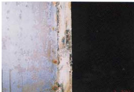
写真 CL2.2.4 補修を施した柱継手の詳細
