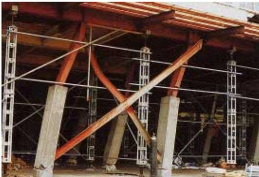
写真 BR1.16.1 筋違の座屈と端部破断
