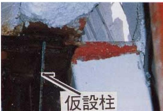
写真 CB1.28.1 柱頭仕口の破断
