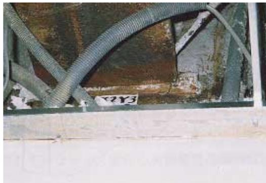
写真 CB1.1.4 エンドタブ付近からの亀裂
