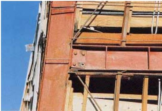
写真 CB2.10.2 梁ウェブ接合ボルトの破断
