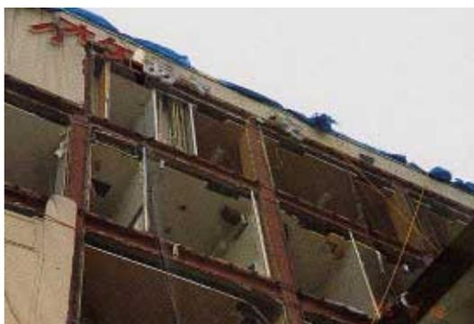
写真 FS3.1.6 上部階 ALC 外壁の落下
