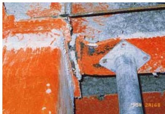
写真 CB1.3.3 梁下フランジの局部座屈と破断
