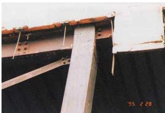
写真 BR1.8.2 柱頭部の塑性化
