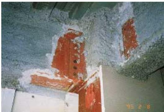
写真 CL1.4.4 ウェブ高力ボルトの破断
