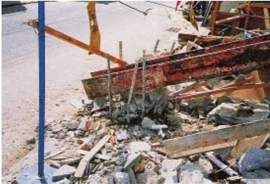
写真 BS3.3.1 柱脚根巻コンクリートの破壊
