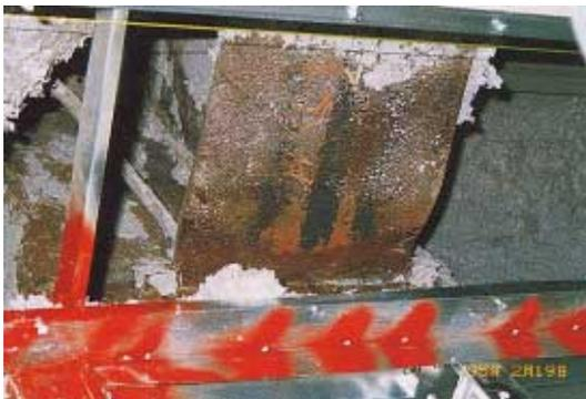
写真 CB1.1.3 下フランジの局部座屈後の破断
