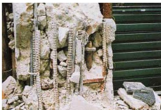
写真 BS3.1.1 根巻コンクリートの破損
