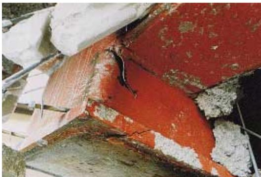
写真 CB1.21.4 中間レベルに内ダイアフラムを設けた段違い仕口の損傷
