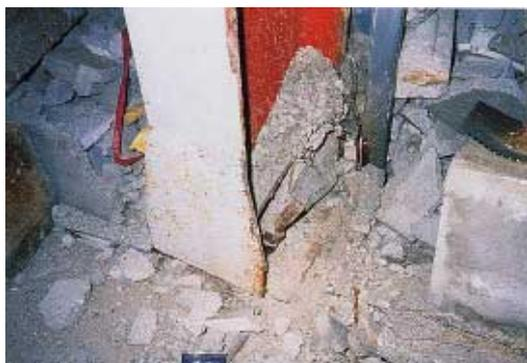
写真 BS1.11.1 柱脚アンカーボルトの損傷
