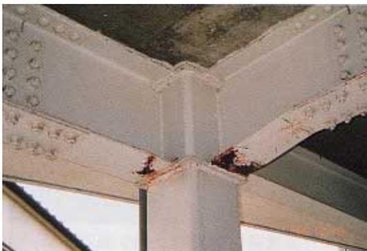
写真 CB1.20.1 梁端部の塑性化
