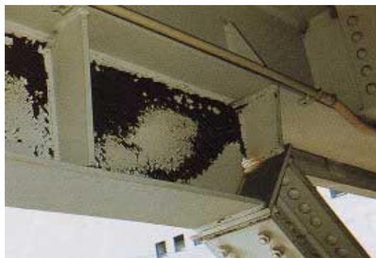
写真 BR1.1.2 筋違上端部の板座屈
