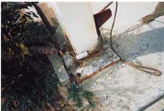
写真 BS1.10.1 アンカーボルトの破断
