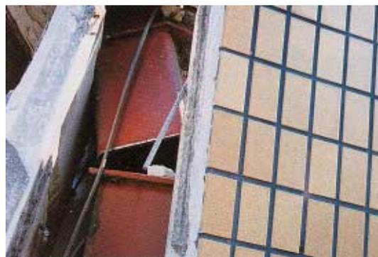
写真 CB1.25.2 柱・梁仕口溶接部の破断
