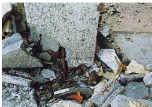
写真 BS1.5.2 アンカーボルトの破断
