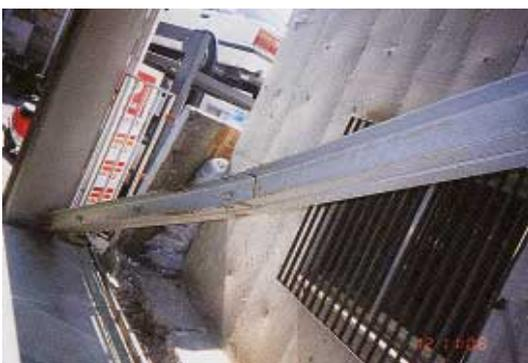
写真 BR1.11.2 筋違の座屈と破断
