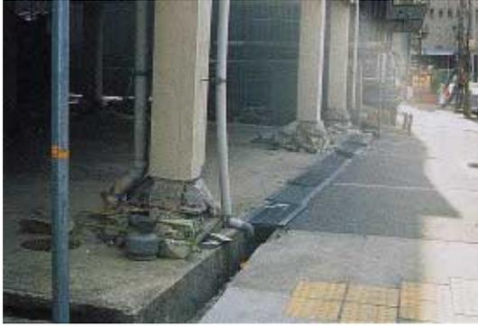
写真 BS1.9.1 仕上げコンクリートの割れ
