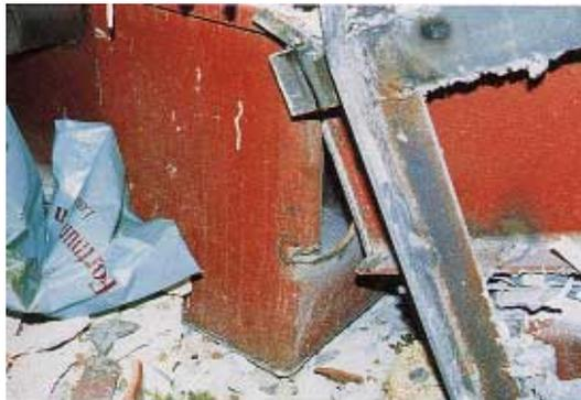
写真CB1.33.1 梁下フランジ溶接部の破断に伴う仕口パネル母材の破断
