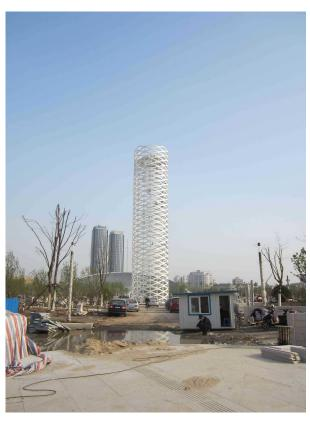
最適化例題> 自重および風荷重に対して、最適なコサインカーブの形状・ピッチおよび部材太さを求めたい。なお、風荷重についての考え方は次ページ参照とする。
