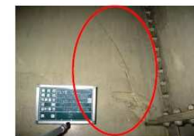
山添橋：主桁の横桁取り付け部付近の長さL=1.1mの亀裂
