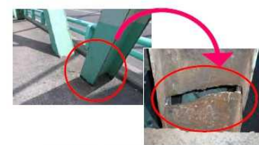
本荘大橋：トラス橋斜材の破断
