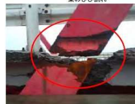
木曾川大橋：トラス橋斜材の破断
