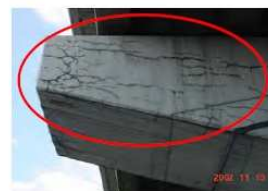
姫路バイパス高架橋：アルカリ骨材反応による橋脚梁のひび割れ
